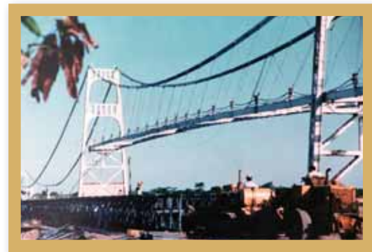
Construcción del Puente de Oro
